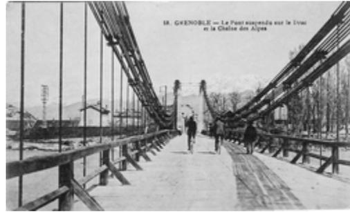
Le tablier et la suspension du pont suspendu de Grenoble à Sassenage
