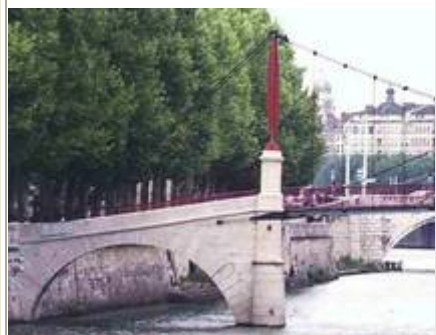
La passerelle St Georges (Lyon) pilier rive droite
