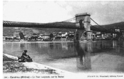
Le pont de Condrieu
