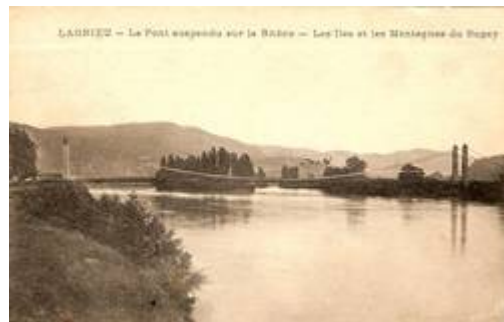
Le pont suspendu de Lagnieu
