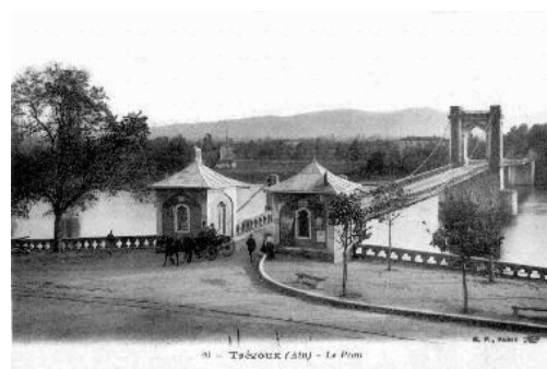
Le pont de Trévoux avec ses pavillons
