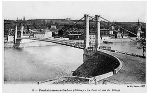
Pont de Fontaines sur Saône
