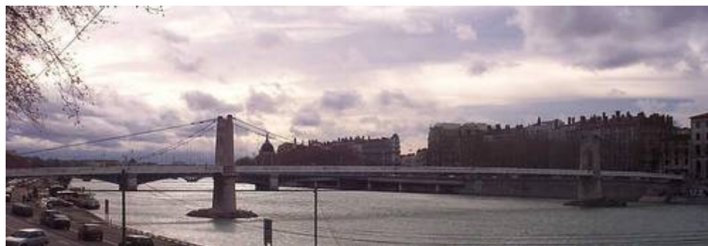
La passerelle du Collège - Rhône - Lyon
