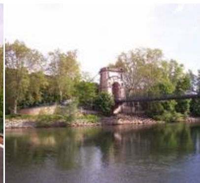
Lyon - Le pont de l'île Barbe vu du quai côté Caluire
