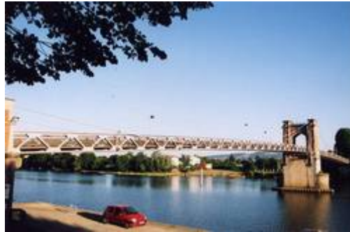
Le pont de Trévoux dans son aspect actuel
