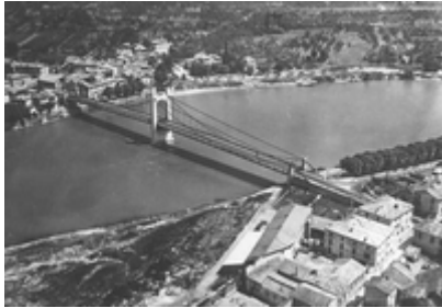
Le pont de Condrieu
