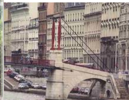
La passerelle St Georges (Lyon) pilier rive gauche
