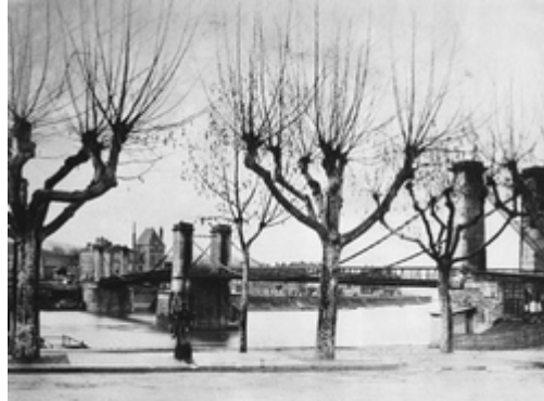
Pont de Neuville sur Saône
