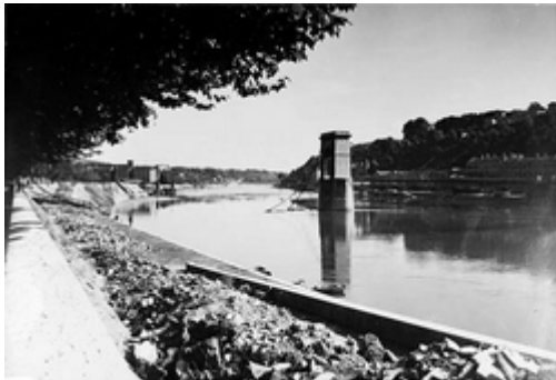
Lyon Vaise - Le pont Mazarik endommagé en 1944
