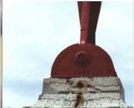
La passerelle St Georges (Lyon) pied articulé de pylone
