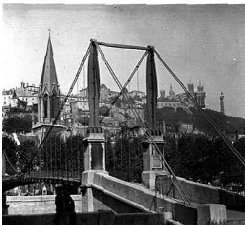
Passerelle St Georges à Lyon
