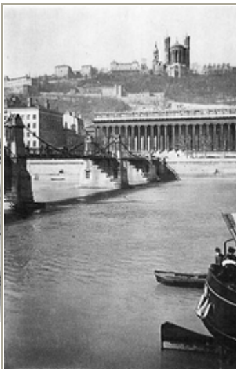
La passerelle du palais de Justice avec le palais en arrière plan
