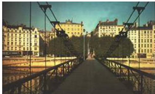
Lyon - La passerelle Saint-Vincent dans son état actuel
