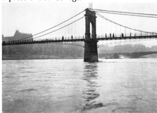
La passerelle du Collège vers 1940
