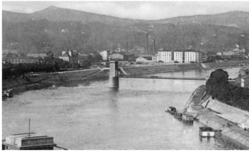
Lyon Vaise - Le pont de la Gare ou Pont Mazarik
