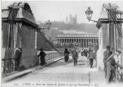
L'entrée de la passerelle
