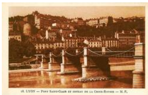
Le pont St Clair (Vaisse) à 5 travées - Lyon
