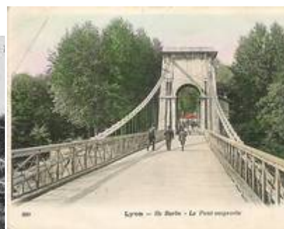
Le pont de l'île Barbe Les chaînes ont disparu au profit de câbles en fil de fer
